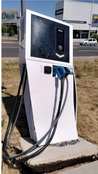
Figure 1 : protection contre les collisions insuffisante
